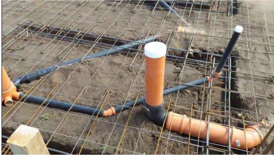
C.2.- Luego de realizada la prueba de estanqueidad, proceder a proteger con una bolsa plástica, cinta de embalaje o similar cada empalme, a fin de evitar que la tierra o mezcla de concreto al momento del relleno pueda ingresar entre la tubería y el anillo de la campana, comprometiendo la estanqueidad del sistema.
